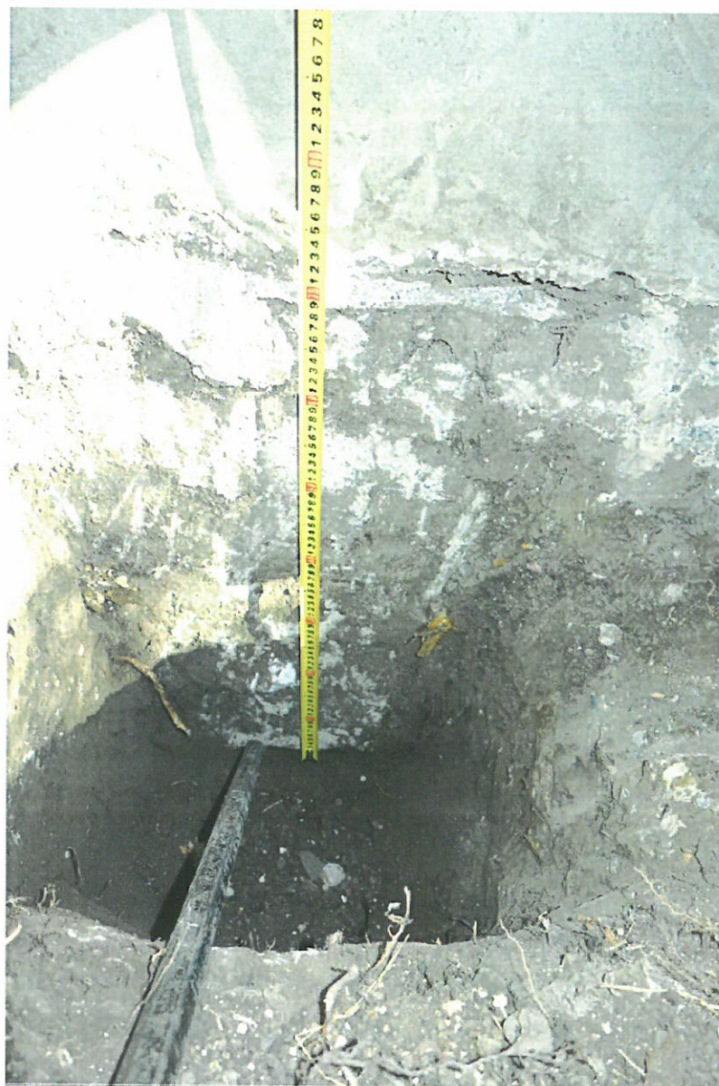
Fig.15: Fundații existente din beton slab armat
