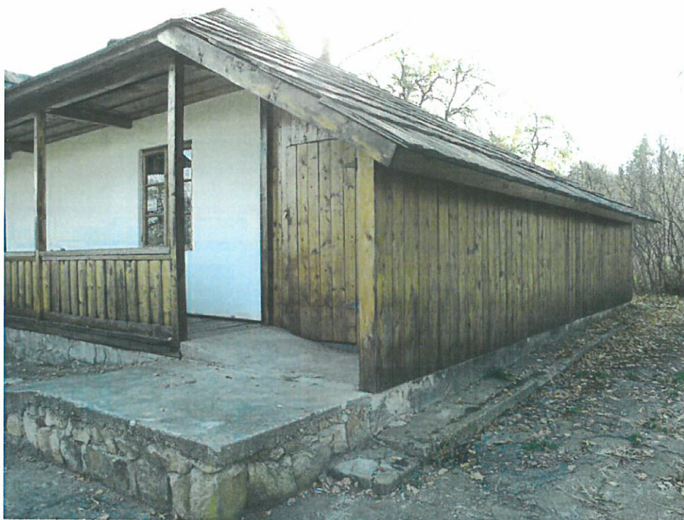
Fig.9: Anexă din lemn
